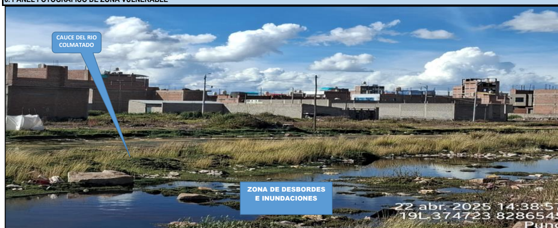
FIGURA 1 y 2: TRAMO CRÍTICO EN LA QDA. LA MOLA ( RÍO TOROCOCHA)., NÓTESE, LA ACUMULACION DE MATERIAL SEDIMENTADO EN EL CAUCE, QUE REQUIERE SER E LIMINADO PARA REESTABLECER LA SECCION HIDRÁULICA DE LA CAJA DEL CAUCE EN ESTE SECTOR.
